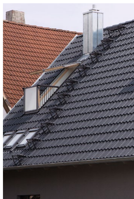
Dachówka ze strzemieniem pod ławę kominiarską
