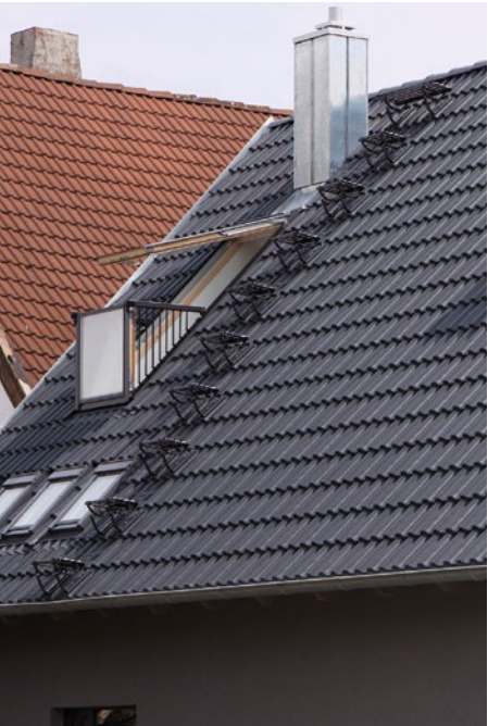
Dachówka ze strzemiem pod ławę kominiarską Funkcja: 4800
